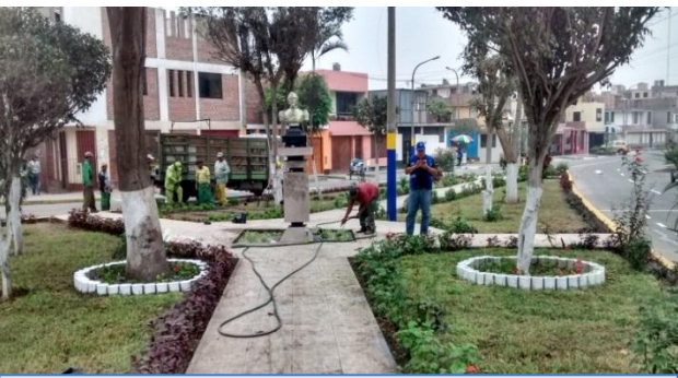
RECUPERACIÓN DE PARQUES
