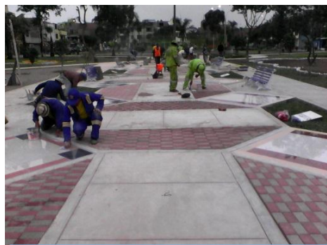
CONSTRUCCIÓN DE LOZA EN EL PARQUE NACIONES UNIDAS – SANTA LUZMILA
